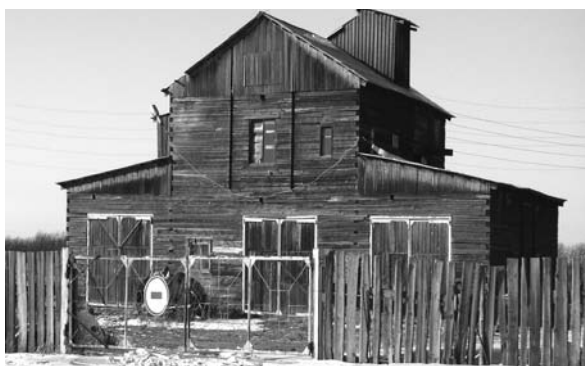
Мельничный комплекс в с. Бондарево к работе готов
